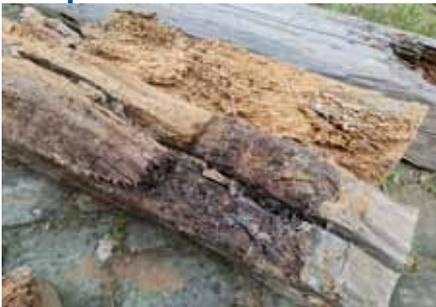
Zahlreiche Balken zeigten Insektenbefall und Hausschwamm und mussten großflächig ausgetauscht werden. Sämtliche Fußpunkte des Dachstuhls waren zu erneuern, um die Dachlast kraftschlüssig abzuleiten. Die Arbeiten am Dachstuhl werden voraussichtlich weitere Jahre in Anspruch nehmen. Eine nächste Bauphase, in der die Orgel für einige Wochen stillstehen muss, ist für Oktober eingeplant.
