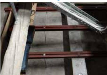
*Stahlanker tragen das Vierungsgewölbe von oben*
